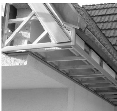
osadené ukonč. profily a prvá lamela
