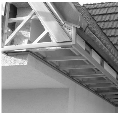
osazené ukonč. profily a první lamela
